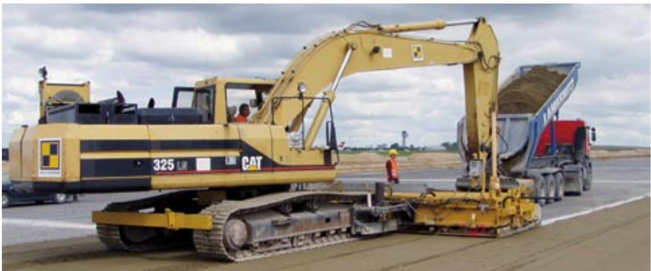
Bild 1: Einbau einer hydraulisch gebundenen Tragschicht mit Multi-Talent
