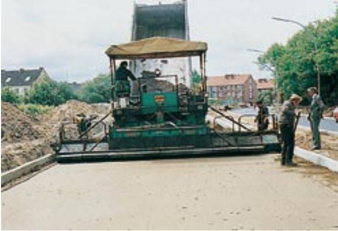
Bild 2: Einbau des Baustoffgemisches für eine hydraulisch gebundene Tragschicht (HGT)
