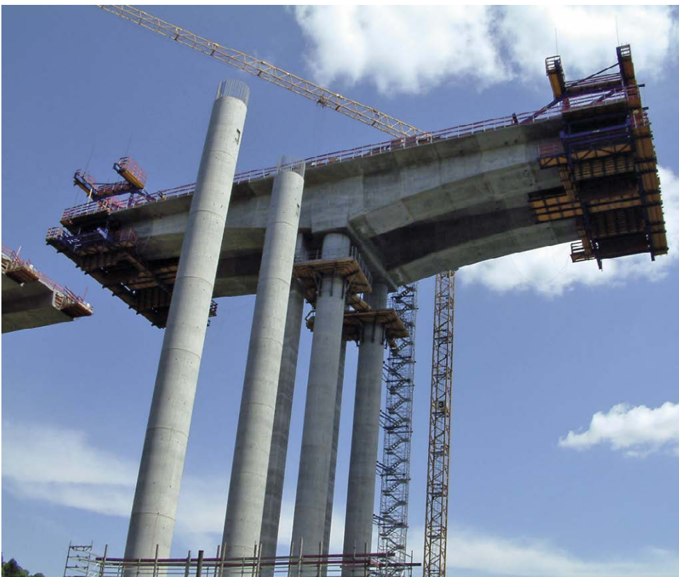
Bild 6: Lahntalbrücke bei Limburg im Bau
