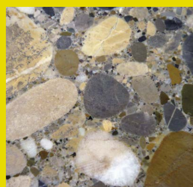
Bild 2: Schnitt durch Nagelfluh, Opus Caementitium und heutigen Normalbeton (von oben) [1]
