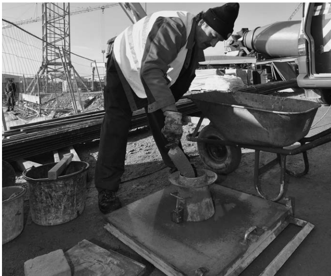
Bild 2: Auf der Baustelle wird u. a. die Frischbetonkonsistenz geprüft.
