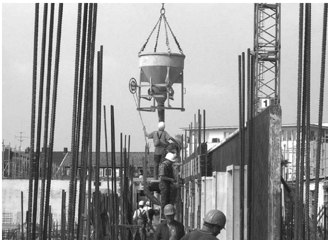
Bild 3: Fördern des Betons mit dem Kübel
