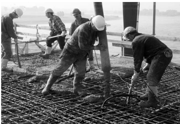
Bild 1: Verarbeiten von Beton auf der Baustelle
