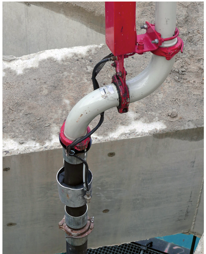
Bild 6: Quetschventil zur kontrollierten Regulierung der Betonsäule
