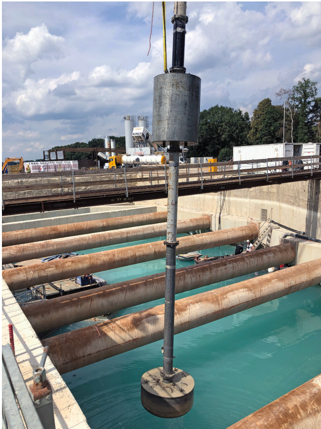
Bild 7: Hop-Dobber im Einsatz – Unterwasserbetonage beim Neubau der Schleuse Gleesen
