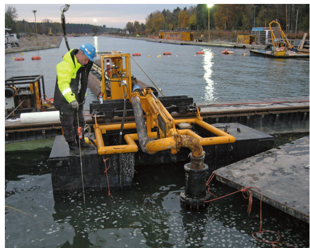
Bilder 1 und 2: Unterwasserbetonage beim Bau der Schleuse Zerben
