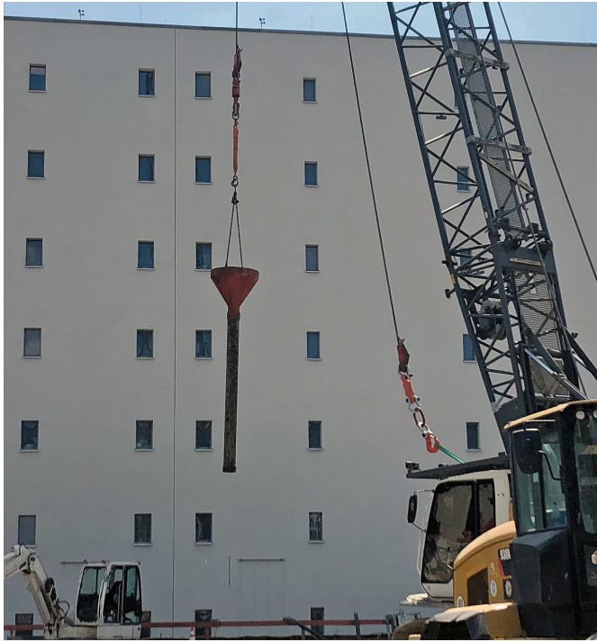
Bild 3: Einbau mit Trichter – Contractorrohr am Kranhaken
