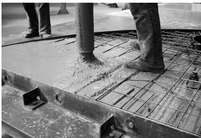
Bild 5: Herstellen eines Deckenelements aus SVB (aus [10])
