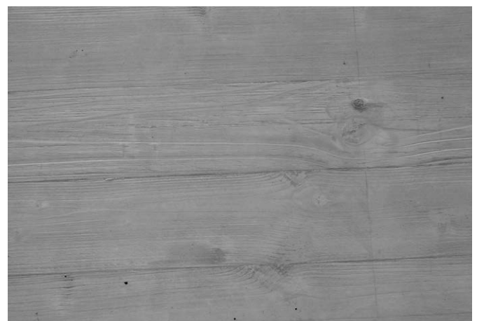
Bild 7: Mit SVB hergestellte Ortbetonwand in Frankfurt (aus [10])
