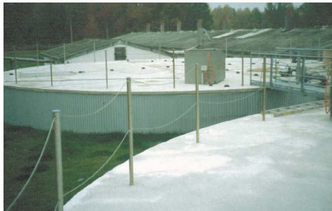
Bild 3: Biogasfermenter mit Betondecke
