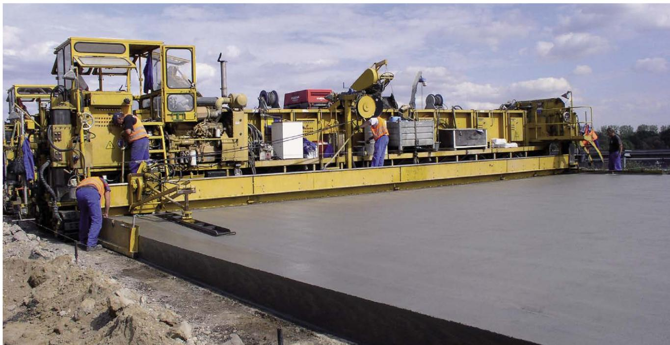
Bild 4: Glätten der fertig eingebauten Betondecke
