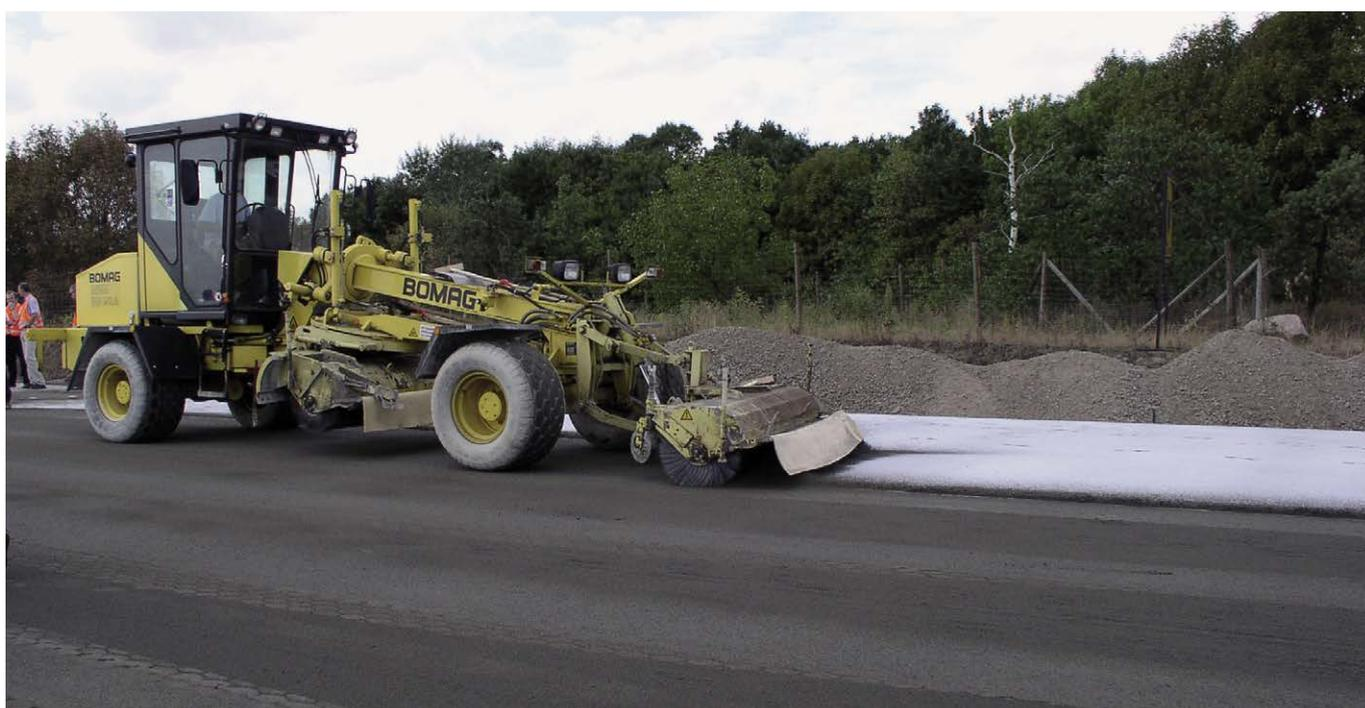
Bild 5: Ausbürsten des Oberflächenmörtels im Nassverfahren
