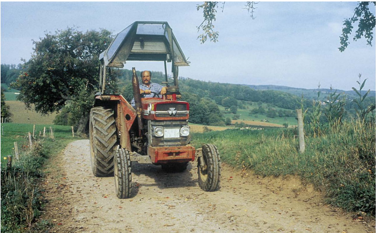
Bild 1: Naturnaher Weg mit hydraulisch gebundener Tragdeckschicht (HGTD)
