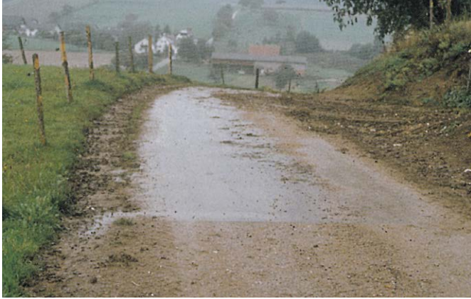
Bild 7: Nasser Asphalt, daneben Trampelpfad der Kühe, vorne Regenwasser haltende, hydraulisch gebundene Tragdeckschicht
