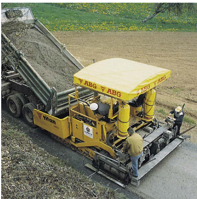
Bild 8: Einbau einer HGTD mit einem Straßenfertiger
