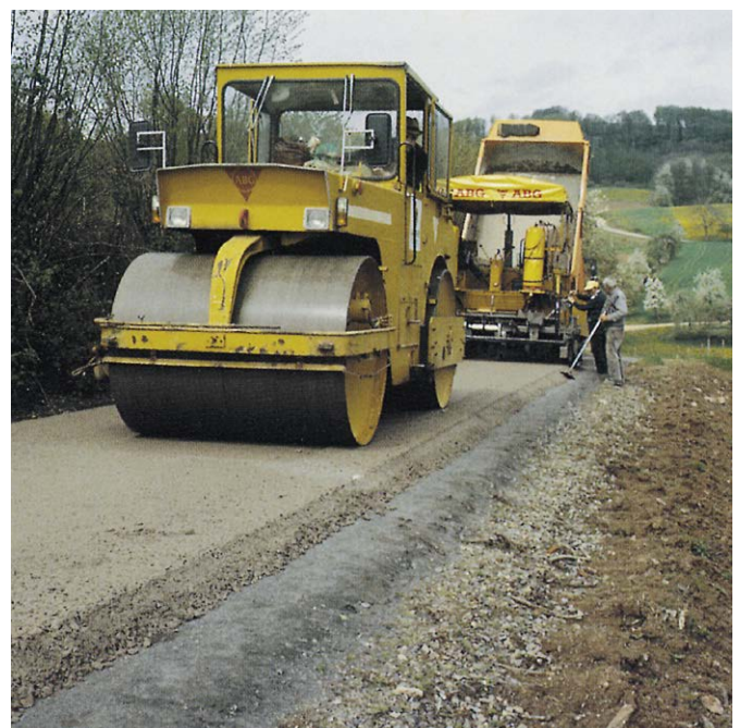
Bild 9: Walzen einer HGTD
